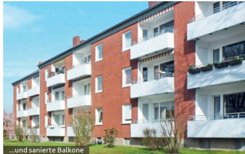
...und sanierte Balkone
