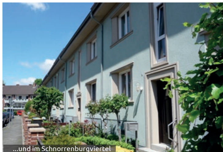
Neue Wohnungseingangstüren an der Cloppenburgstraße ...
