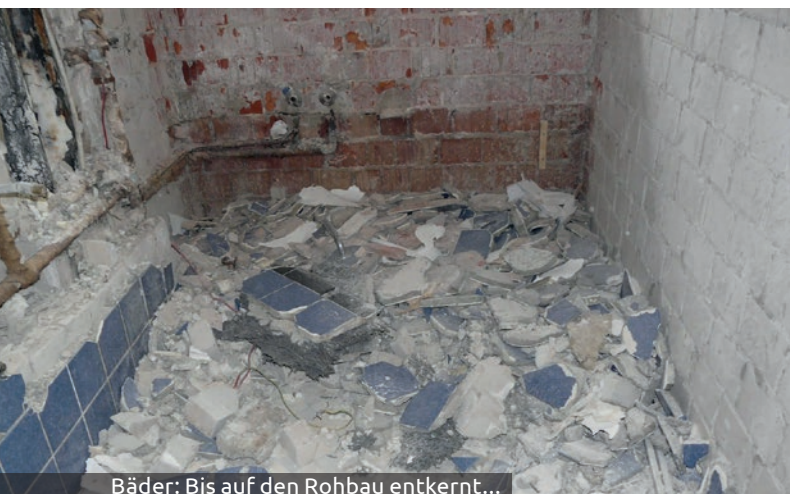
Bäder: Bis auf den Rohbau entkernt...
