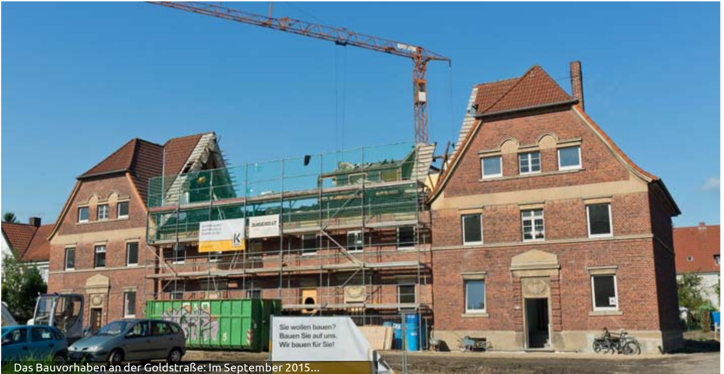
Das Bauvorhaben an der Goldstraße: Im September 2015...
