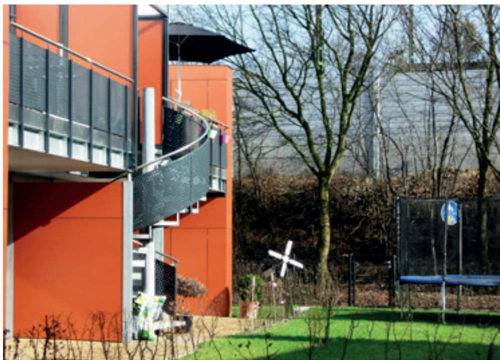
Wismarweg mit neuer Lärmschutzwand
