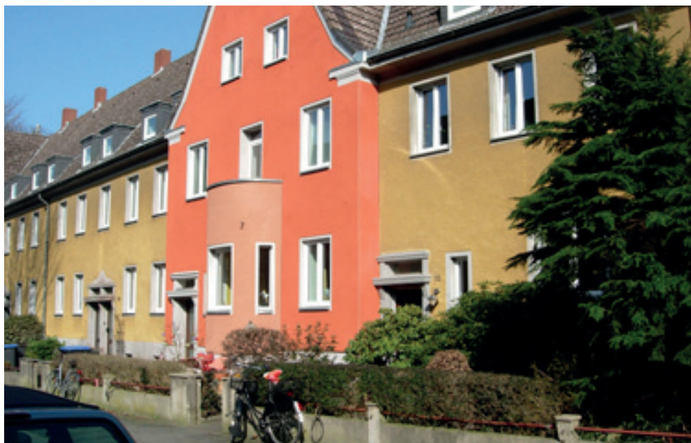
Häuser auf der Görresstraße mit neuen Fenstern
