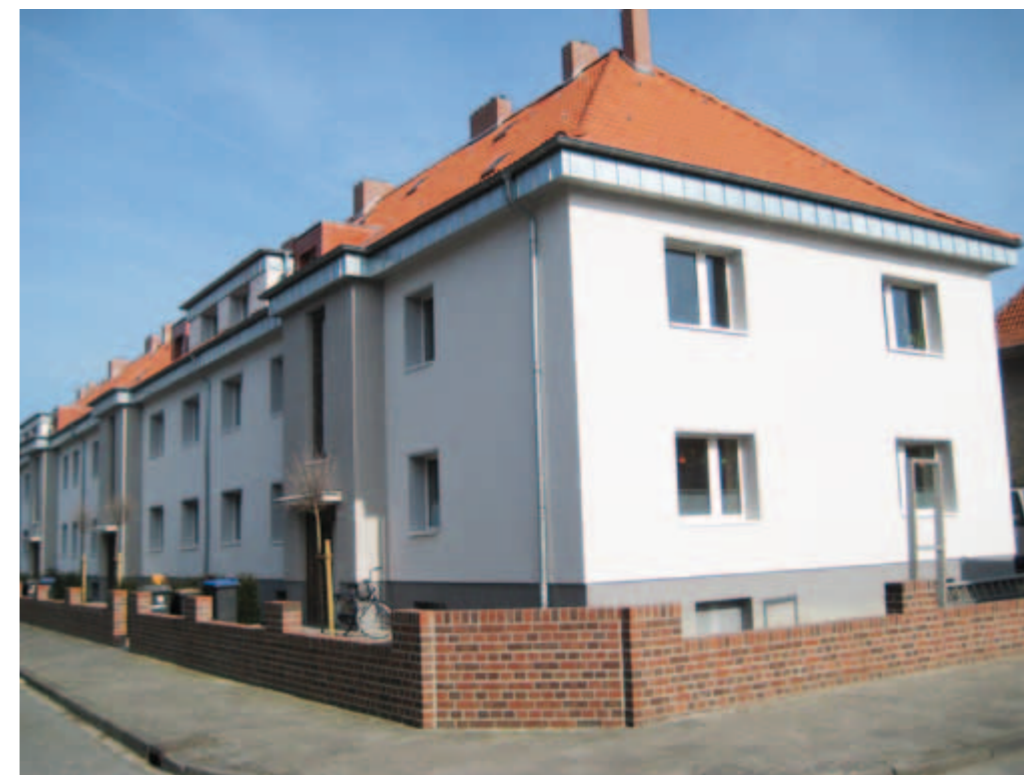
Vinzenzweg nach der Sanierung
