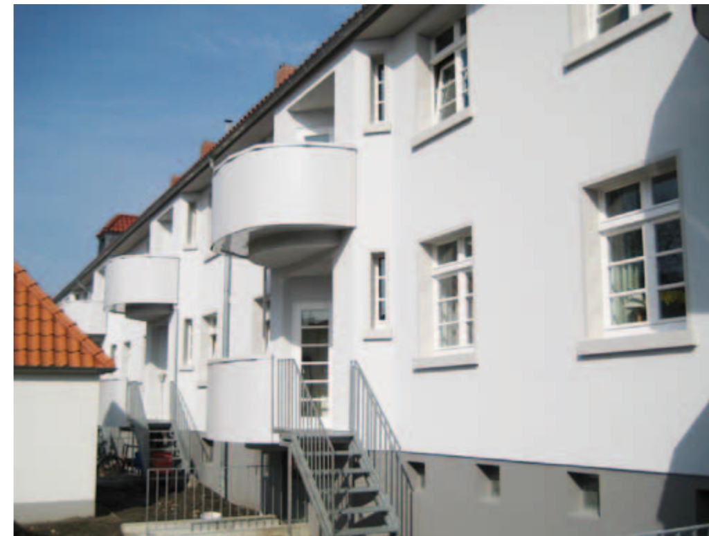
Rheinstraße nach der Sanierung
