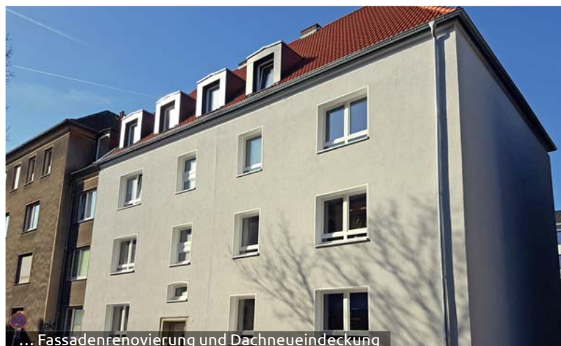
... Fassadenrenovierung und Dachneueindeckung
