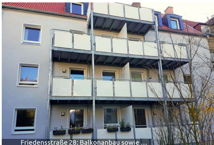
Friedensstraße 28: Balkonanbau sowie ...
