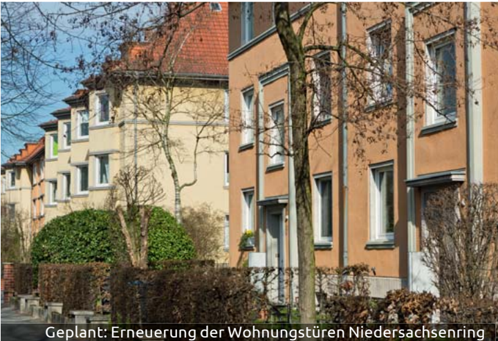
Geplant: Erneuerung der Wohnungstüren Niedersachsenring
