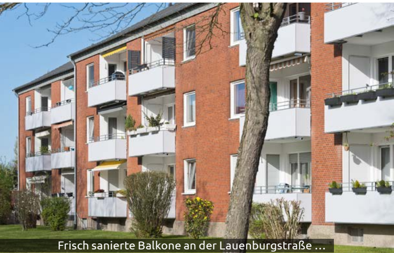
Frisch sanierte Balkone an der Lauenburgstraße ...
