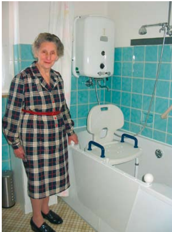
Franziska Hackmann (94) ist unser drittältestes Mitglied. Ihr Badezimmer ist bereits seniorenrecht umgebaut worden. Dank des herausnehmbaren Wanneneinstieges und des Wannenslifers ist das Sturzrisiko hier minimiert.
